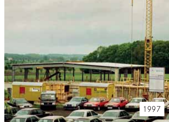
Rohbau der neuen Ausstellungshalle 1997.
